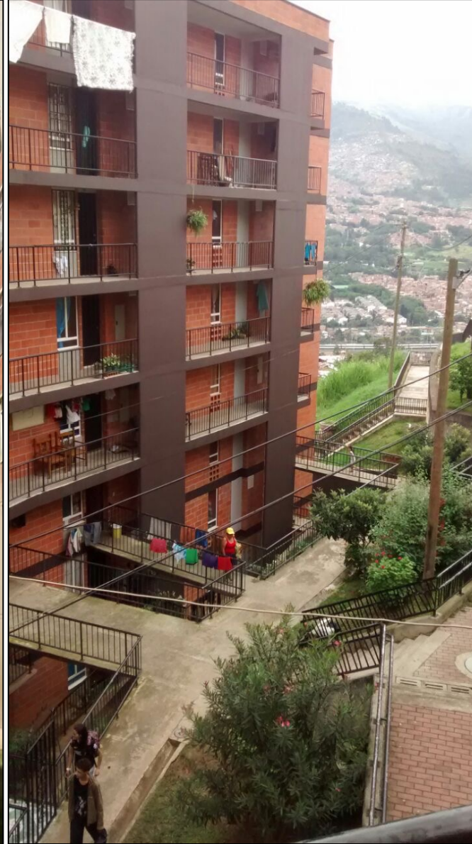
Reasentamiento en Quebrada La Herrera
