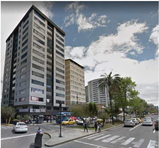
Edificaciones que demuestran el nivel de sobre-consolidación ubicado en la zona entre la Av. 6 de Diciembre y 12 de Octubre
