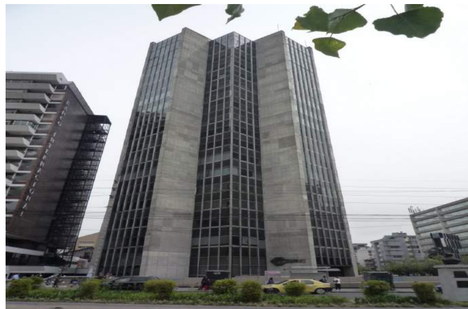
Edificio COFIEC Ubicado en la Av. Patria y Amazonas Estructura de hormigón armado.
