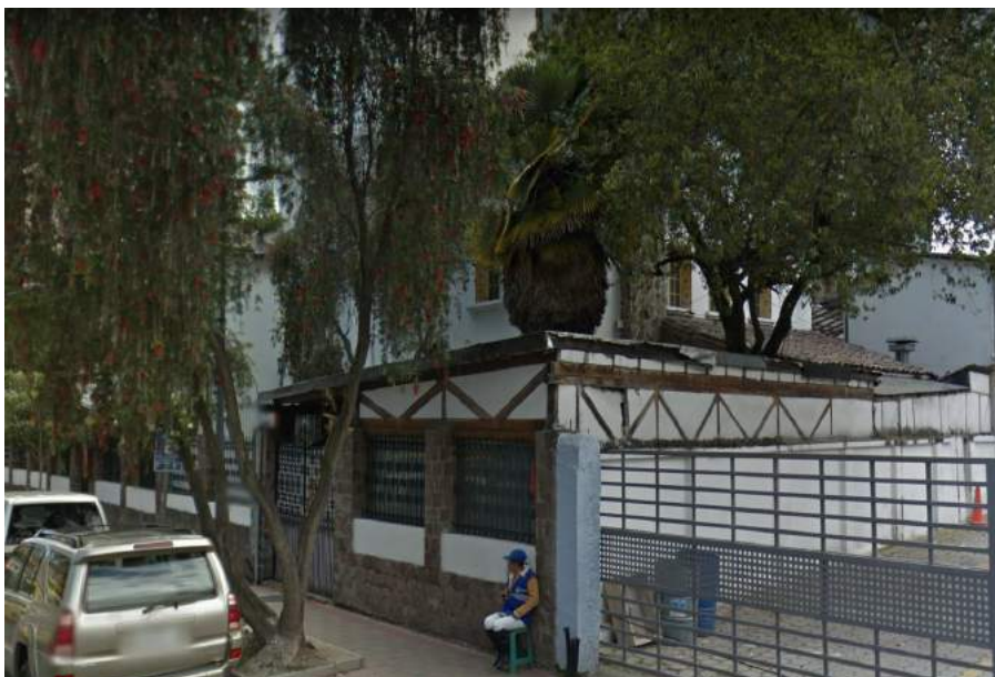
Ubicado en la calle Gral. Robles. Presenta estructura de madera.
