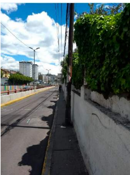
Acera que no cumple con las condiciones mínimas de caminabilidad debido a que presenta obstáculos en el trayecto y su ancho es precario. Foto tomada en la acera de la calle Gral. Robles, Palacio de Barba.
