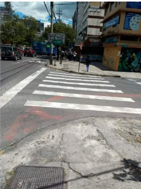
Cruce peatonal regular. Rampas no definidas y regular estado de la materialidad. Foto tomada en la calle Carrion y Av. 12 de Octubre. Fuente: Fotografía propia.
