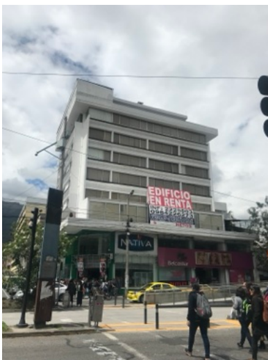
8.- Edificio Av. 10 de agosto frente al Parque Julio Andrade
