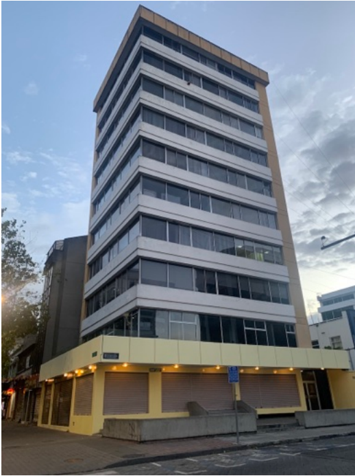
15.- Edificio calle Ramírez Dávalos y Amazonas
