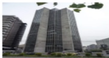
Edificio COMEC Ubicado en la Av. Patria y Alcazar Estructura de hormigón armado.
