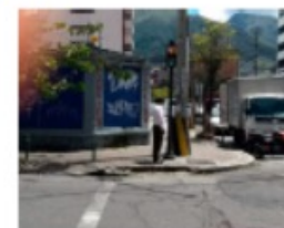
Cruce peatonal malo. Presencia de obstáculos en trayecto, difícil de rampa, mal estado de la materialidad, paso sobre no definido.
