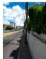
Acera que no cumple con las condiciones mínimas de caminabilidad debido a que presenta obstáculos en el trayecto y su ancho es precario. Foto tomada en la acera de la calle Dral. Rubio, Palacio de Berbo.
