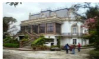
Palacio de Berbe Dirección: Calle Jorge Washington y Avenida 12 de Octubre Sector La Mariscal Año de construcción: circa 1900 Arquitecto: Francisco Durán Cárdenas (atribuido) Estilo: Neorrenacimiento (Neorrenacimiento) Presión: Patrimonio de la ciudad Uso actual: Vivienda privada
