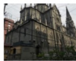
FOTO 3: Foto de la Iglesia Católica Santa Teresita, ubicada en la 9 de octubre entre Roca y Bolívar.
