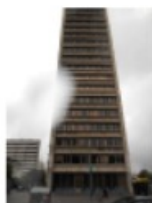
Edificio CPN-Sangreates, 1981 Arquitecta: Odo Wappenstein Fotografía tomada desde la Av. Patria
