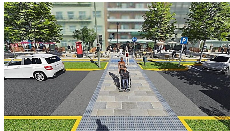
Imagen 23: plataforma a media cuadra, ayuda en el cruce para personas en silla de ruedas y reduce la velocidad de los automotores
