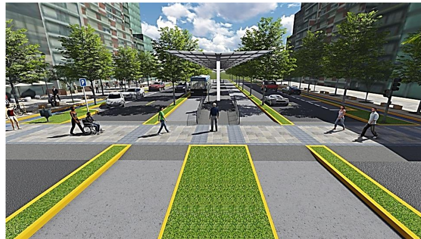
Imagen 15: vista de calle arterial A1
