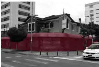
a.1. “Caja de Cristal” mal ejecutada La Mariscal. Quito, Ecuador. 2020
