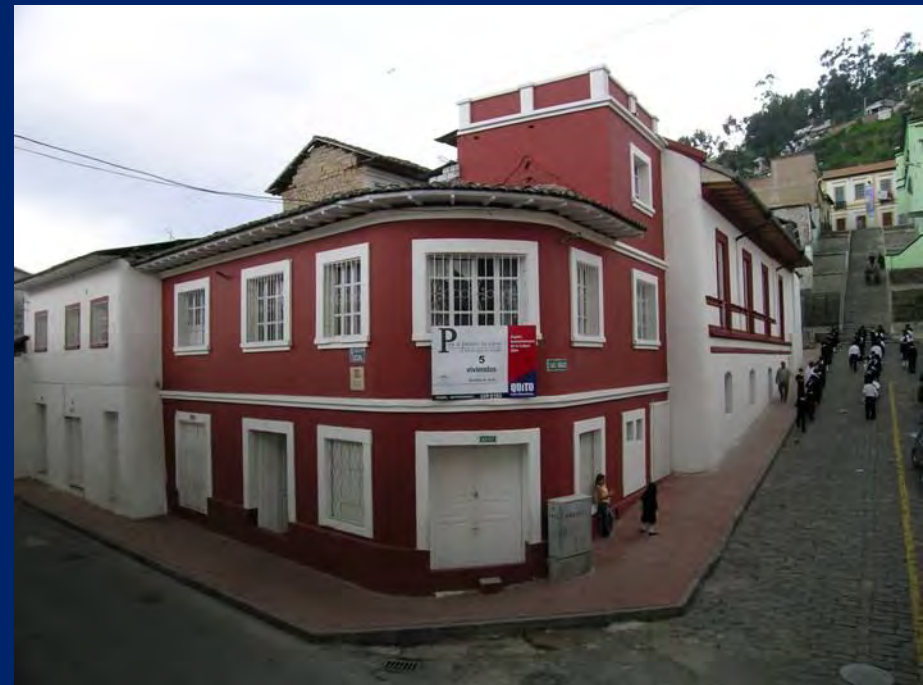
Barrio San Sebastián, calles Loja y Mazo 6 viviendas
